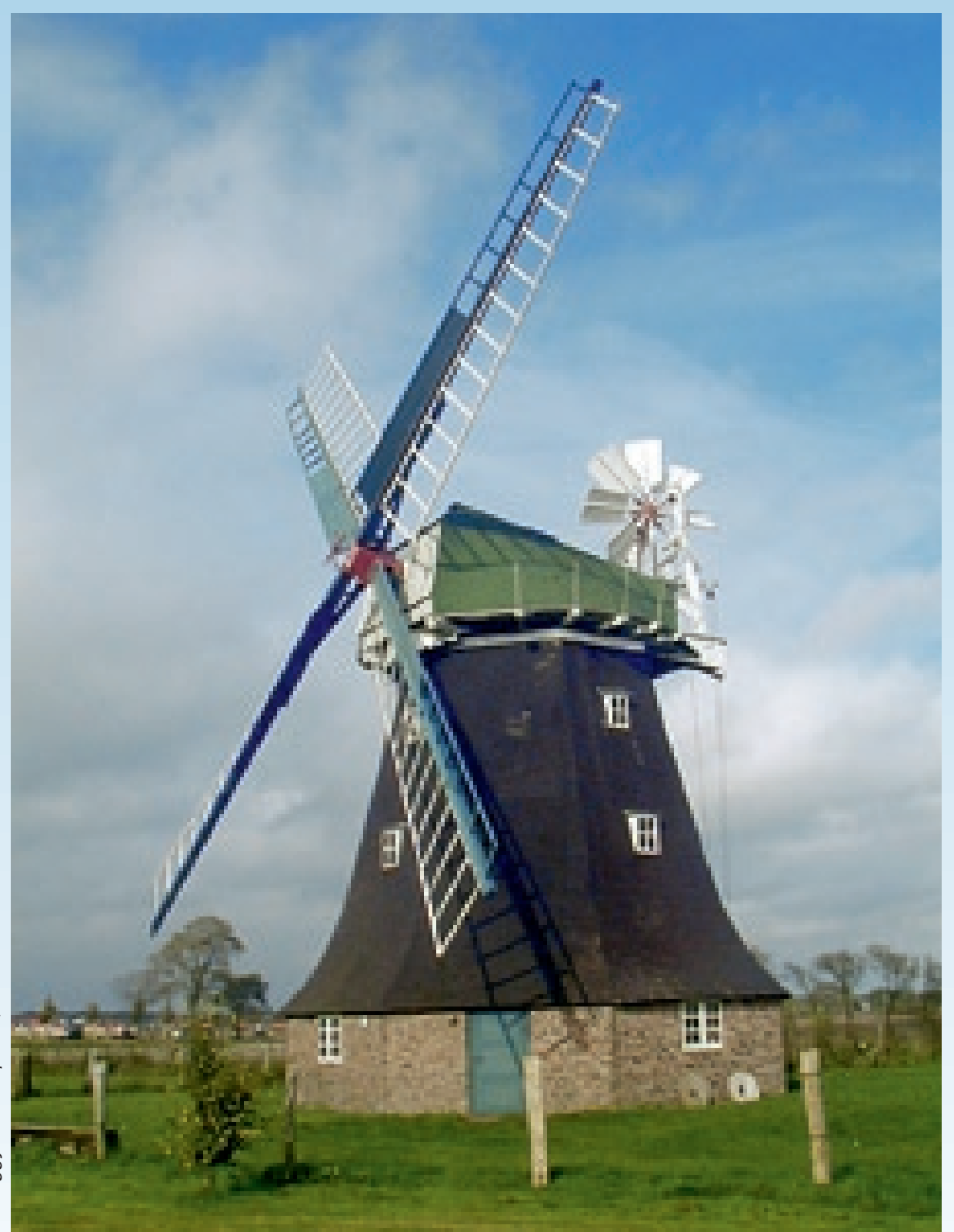
Holländerwindmühle: nur die Kappe ist zur Windachsführung des Rotors drehbar.
