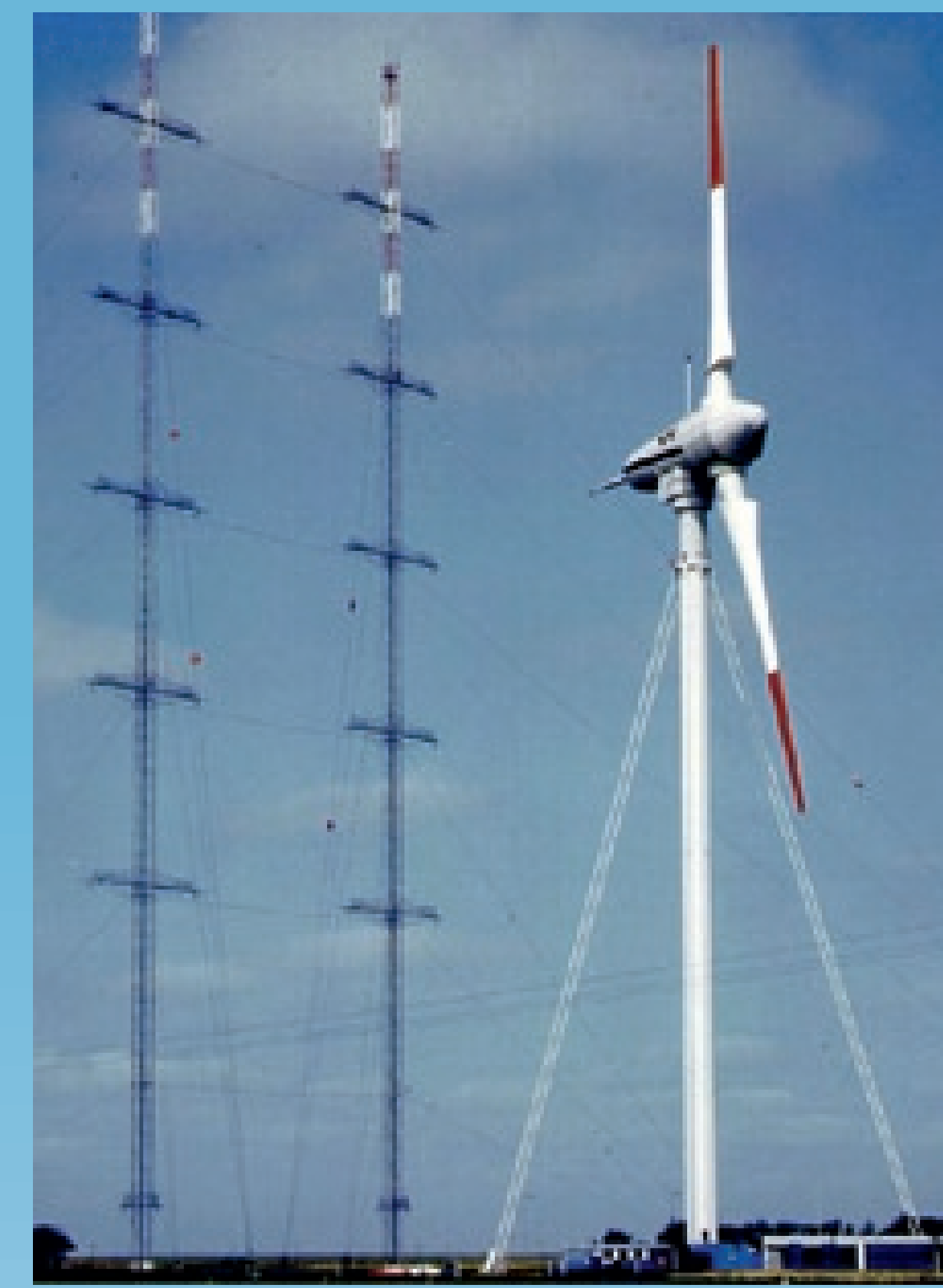
Die Fehlschläge der 80er Jahre – oben: GROWIAN, zweiflügliger Leeläufer, 3 MW, Deutschland; unten rechts: EOLE, vertikaler Darrieus-Rotor, 4 MW, Kanada;
