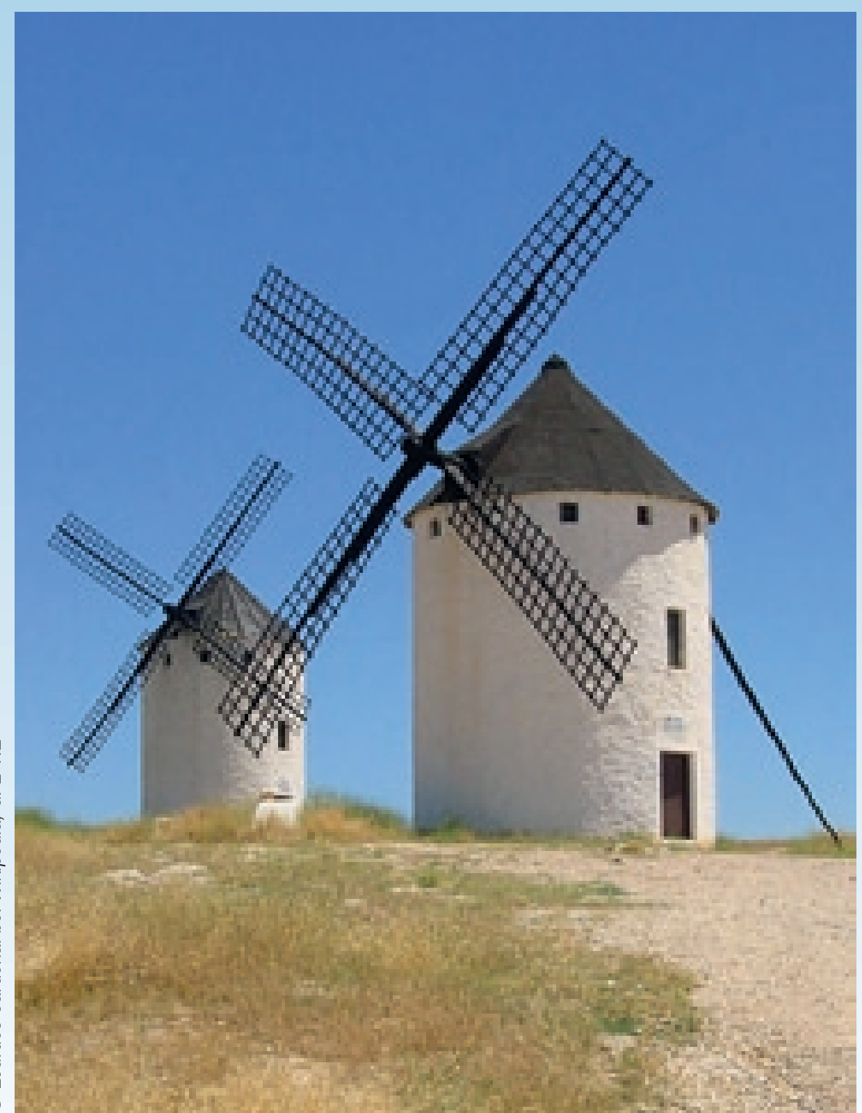
Turmwindmühlen bei La Mancha: der Rotor ist fest in Hauptwindrichtung montiert.
