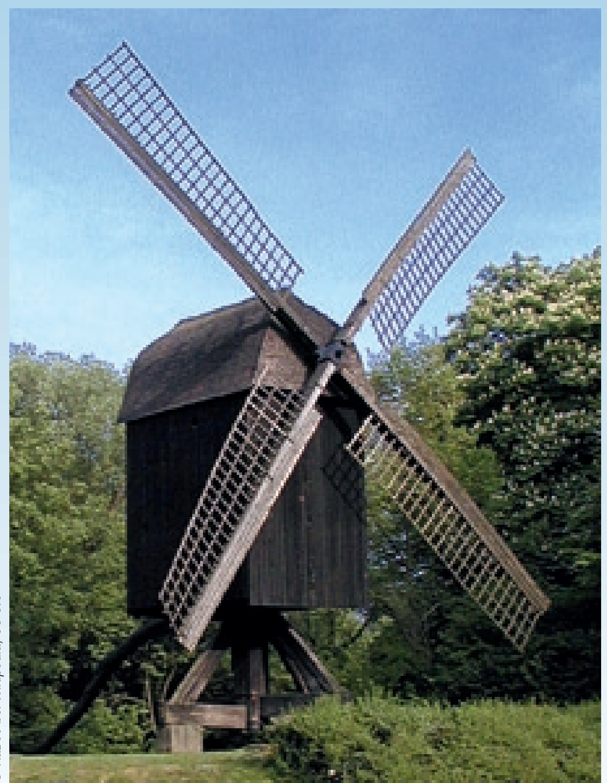
Bockwindmühle bei Hannover: das gesamte Mühlenhaus wird in den Wind gedreht
