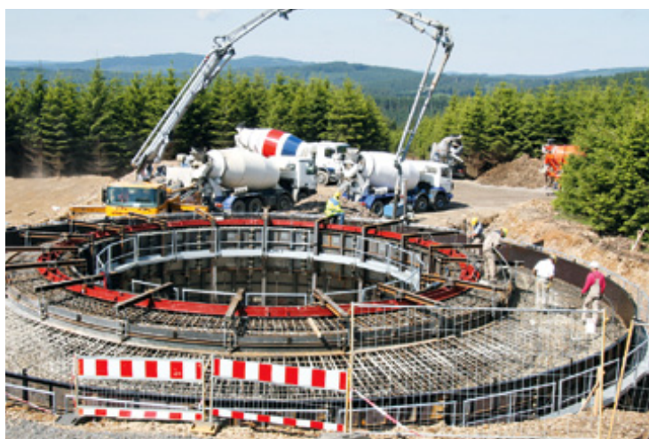
Das Fundament einer Anlage im Bau: Schon die Logistik war eine Herausforderung angesichts ca. 1700 Transporte mit bis zu 45m Länge.
